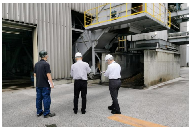
現場確認（スラグ排出口）
